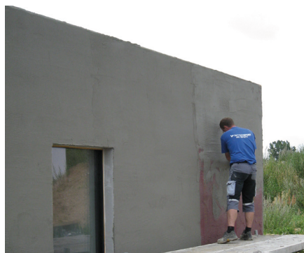
Færdig overflade på armeringsmørtel til Filtspuds skal fremstå jævn og lidt ru. Dette kan gøres med en stålbørste eller en stiv kost.
