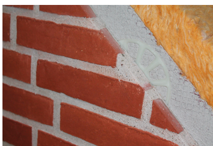
Ved opsætning af teglskaller anvendes ISOVER Pudsskive Ø 65 mm og ISOVER Pudsskive Plus Ø 140 mm.
