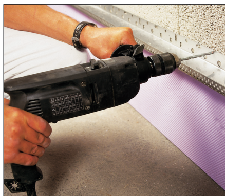
Sokkelskinnen sættes fast med sømdybler med 330 mm mellemrum.
