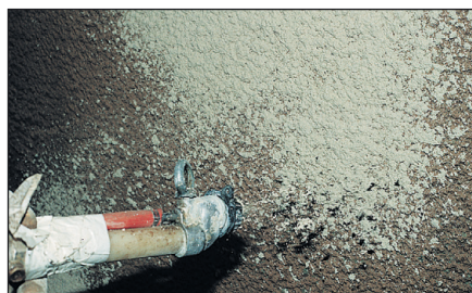
Mørtelen kan også påføres med pudsmaskine.
