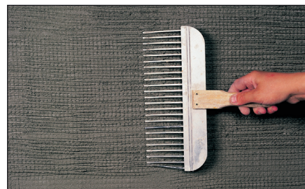
Færdig overflade på armeringsmørtel til Filtspuds skal fremstå jævn og lidt ru. Dette kan gøres med en stålbørste eller en stiv kost.
