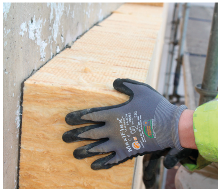
Lamellerne masseres godt fast ind mod muren.
