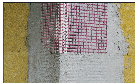
Hjørneprofilen skal opsættes inden armeringsmørtelen.
