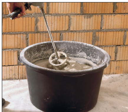
Klæberen blandes i en balje. Rør rundt med piskeris.
