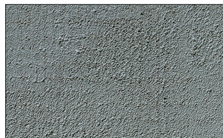
Færdig overflade på armeringsmørtel til strukturspuds skal fremstå jævn og glattet.
