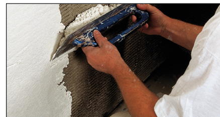
Påføring af Filtpuds med 6 mm tandspartel.
