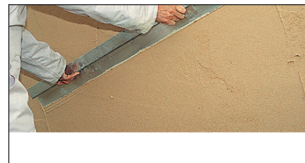
Kambedet udglattes med en retholt, så overfladen fremstår glat og jævn.
