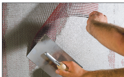
Armeringsnettet lægges i den yderste del af mørtelen. Overlæg skal være min. 100 mm.
