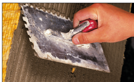
Armeringsmørtlen trækkes på med 14 mm. tandspartel til bestemmelse af lagets tykkelse (7mm.).
