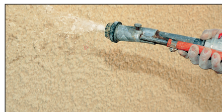
Strukturpuds påføres med mørtelpumpe.
