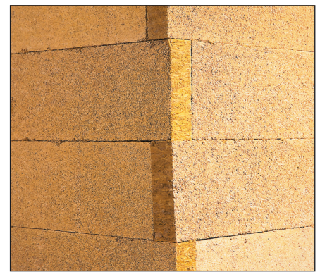
Ved udgående hjørner skal isoleringen også opsættes i forbandt. Husk at maskinskåret kant skal vende udad.
