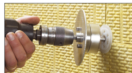
Dyblen skrues og fræses ind i isoleringen i én arbejdsgang.
