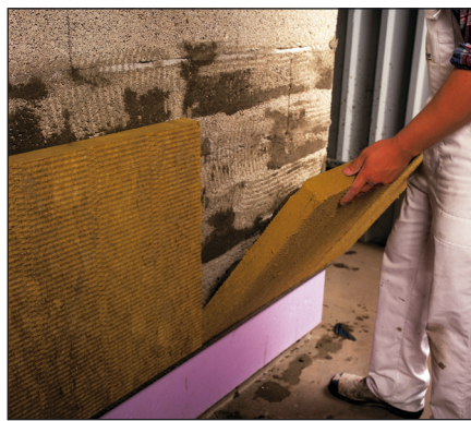
Isoleringen opsættes med start ved hjørne og i bunden ved sokkelskinne. Næste række opsættes i "halvstens" forbandt.
