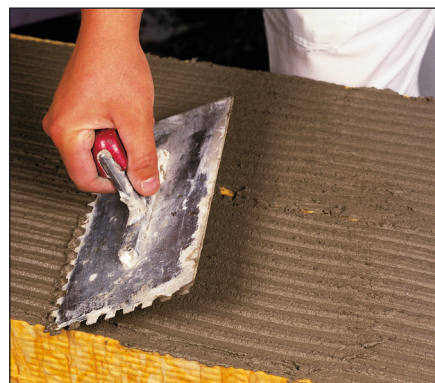
Klæberen til træunderlag påføres enten isoleringen...
