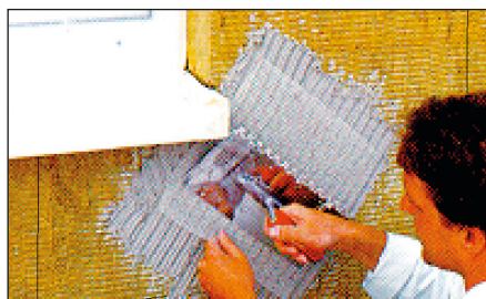
Hjørner forstærkes med diagonalnet.
