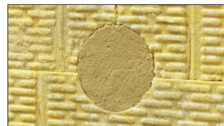
Isoleringsoverfladen bliver helt plan.
